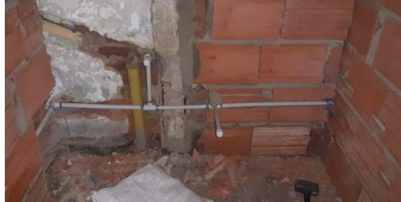
Instalación de red hidráulica
