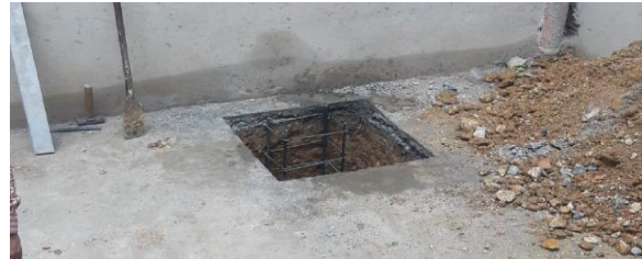
Excavación e instalación parrilla
