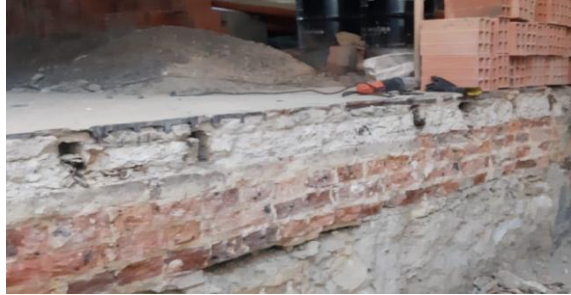
Inicio de construcción de viga cinta
